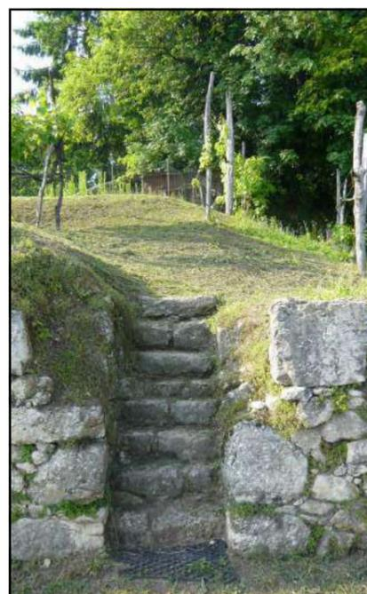
Elementi di salita ai coltivi. Dai sentieri principali o dalle strade si accede ai terreni coltivati a volte con delle opere di estremo interesse architettonico. Nel caso specifico la costruzione di un muro di terrapieno ha permesso di regolarizzare le pendenze del campo. Il maggior dislivello con il percorso principale è stato risolto costruendo una scala incassata che durante le piogge funge da scarico per le acque
